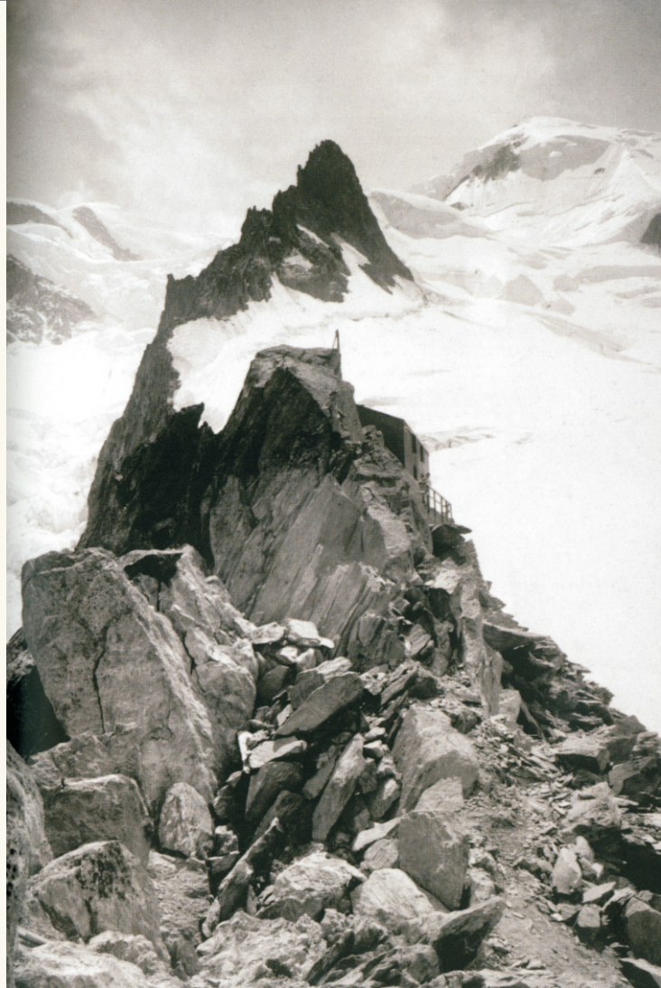
Observatórium na Mont Blancu vo výške 4808 m n. m.
