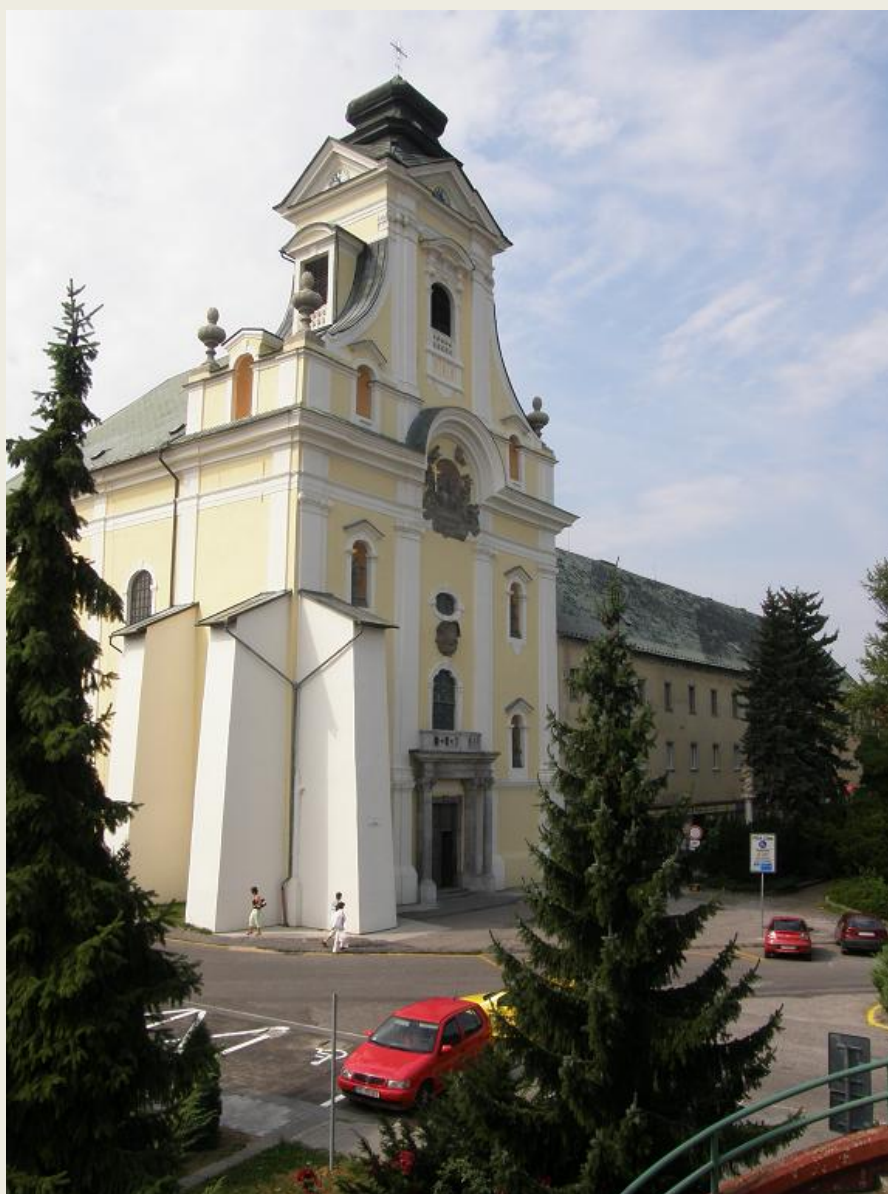
Pohľad na kostol Nanebovzatia Panny Márie s kláštorom piaristov v Prievidzi
