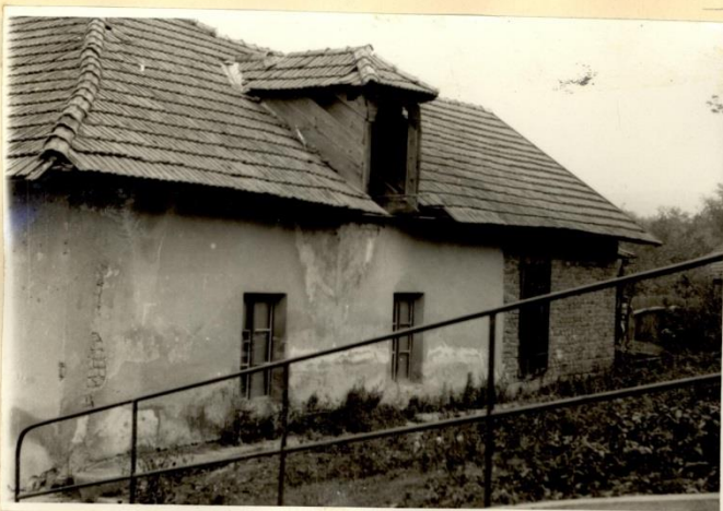
POHLED OD JIHU.
