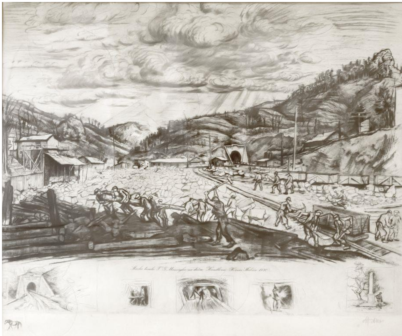
Tunelové nádvorie pred handlovským portálom (lept A.J. Alexa) počas stavby
